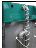
Version chauffante, raccordement à un circuit en boucle avec un câble chauffant
